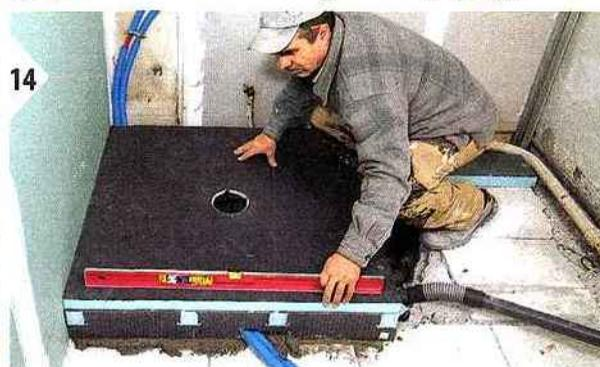
**13** À l'aide de mortier colle, fixez au sol le kit de rehausse après l'avoir relié à son évacuation. Contrôlez précisément l'horizontalité de l'ouvrage (dans les deux sens).
