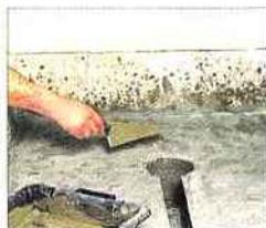
Si elle n'a pas besoin d'être en pente, la dalle doit comporter une réservation pour l'évacuation à gros débit (horizontale ou verticale, Ø 40 ou 50 mm).
