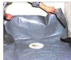
Soudée autour de la bonde, la membrane en PVC, comprise dans ce kit (« Isotanche » de Lazer), recouvre la dalle et les murs [sur h. 15 à 20 cm].
