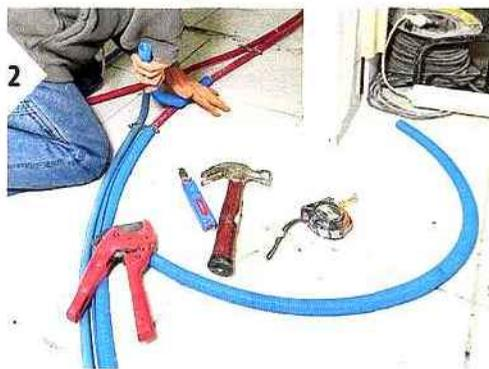
**1** Les arrivées d'eau sont réalisées en tubes PER. Fixez les tubes au sol à l'aide de colliers jumelés.
