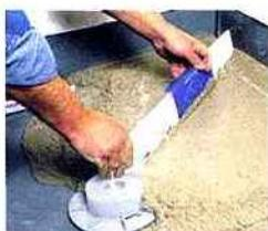
La pente en direction de la bonde s'obtient lors du coulage de la chape de 30 à 50 mm d'ép. : facilitée par un système de règles extensibles, l'opération permet d'avoir une douche carrée ou rectangulaire de 70 à 120 cm de côté.
