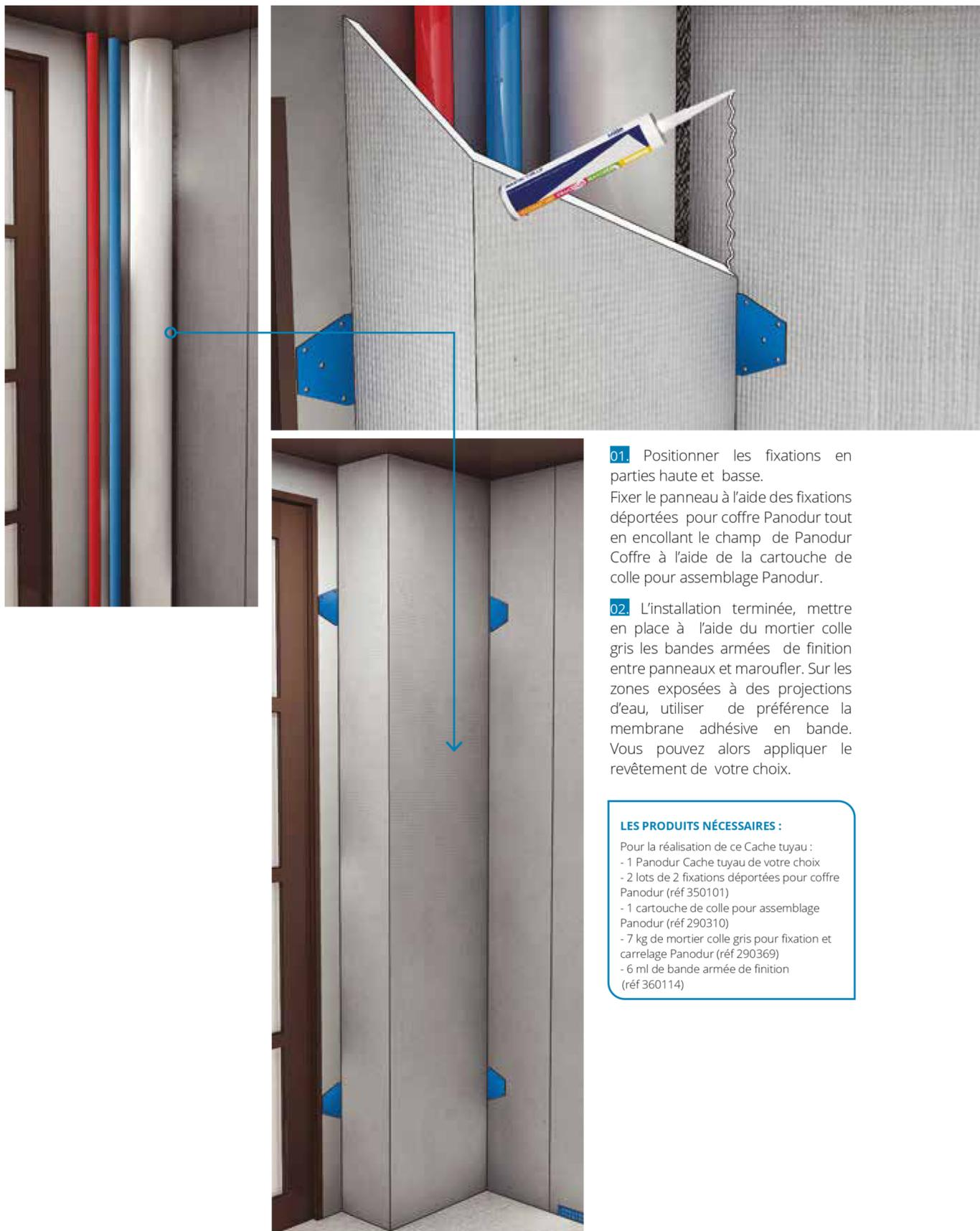
**01.** Positionner les fixations en parties haute et basse. Fixer le panneau à l'aide des fixations déportées pour coffre Panodur tout en encollant le champ de Panodur Coffre à l'aide de la cartouche de colle pour assemblage Panodur.
