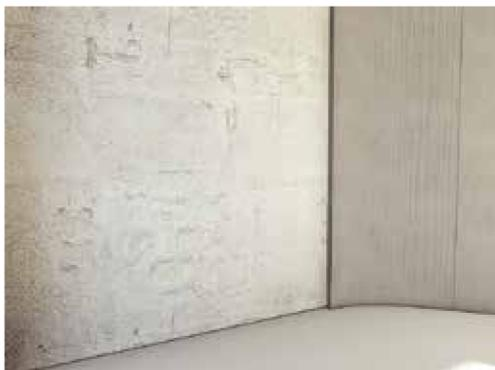
01. Appliquer une couche de mortier colle gris de fixation Panodur sur la partie haute de Panodur Mural et peigner à l'aide d'une taloche crantée de 8 mm.
