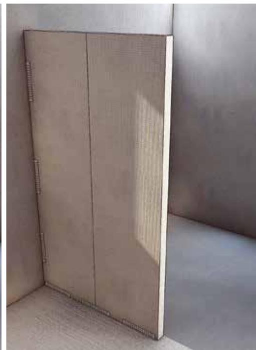
gris, les bandes armées de finition entre les panneaux muraux et le sol et maroufler. Sur les zones exposées à des projections d'eau, utiliser de préférence la membrane adhésive en bande.
