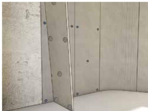
colle gris les bandes armées de finition entre panneaux et maroufler. Sur les zones exposées à des projections d'eau et en pied de cloison, utiliser de préférence la membrane adhésive en bande pour angle sol et mur.
