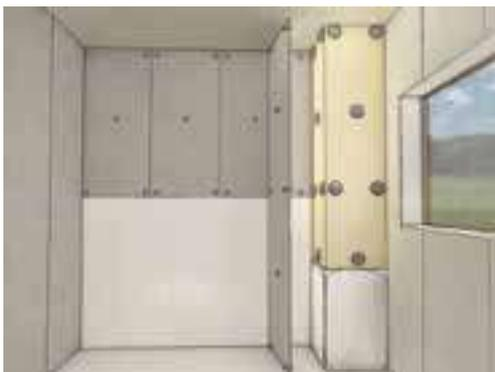
01. Appliquer sur le carrelage existant une couche de mortier-colle gris de fixation Panodur à l'aide d'une taloche crantée de 8 mm.
