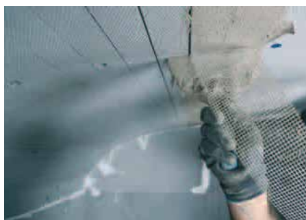
Réalisation de l'étanchéité
