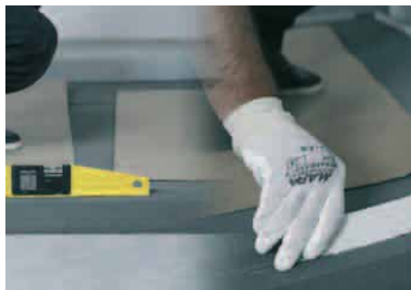
Pose du sol
