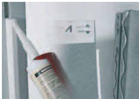
Pose des murs
