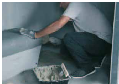
Pose des bancs
